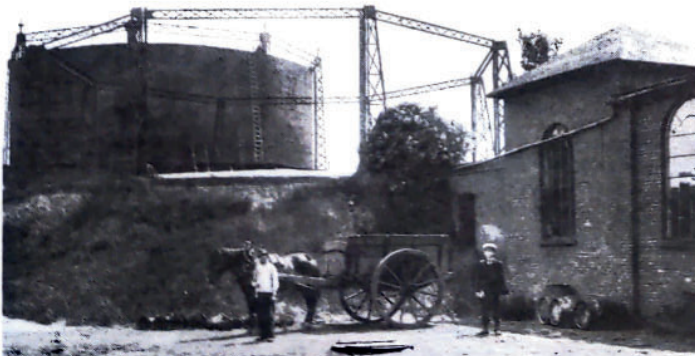
Gasbehälter am Gaswerk (heute Ebertstraße) um 1900. Wie sich doch die Zeiten ändern: Statt Pferd und Karren verfügen die SWB heute über einen gut ausgerüsteten Fuhrpark, um jederzeit zur Stelle zu sein.
