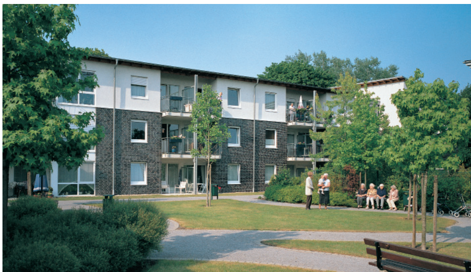
Nahwärme wird besonders gerne zur Versorgung von Wohnanlagen eingesetzt
