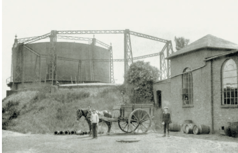
Bild vom hinteren Betriebshof aus dem Jahre 1901: links die beiden Gasspeicher aus den Jahren 1860 (vorne) und 1885 (hinten), rechts das Apparatehaus.
