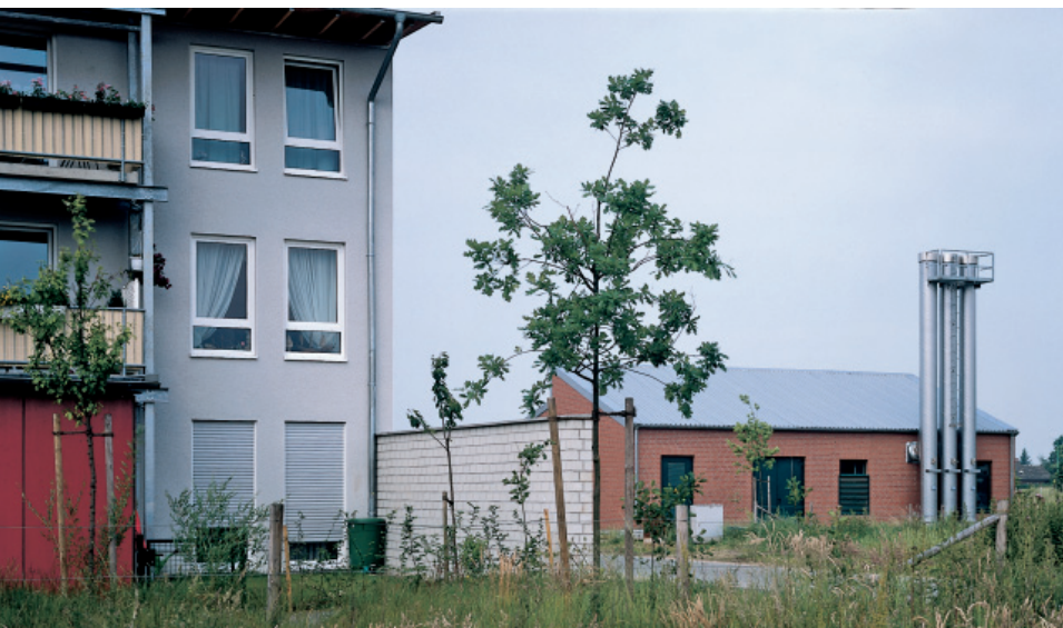
Die Nahwärmestation in der Feldmark (rechts im Bild) versorgt weit über 500 Wohneinheiten
