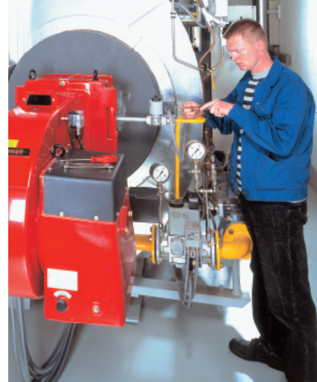
Ein BEW-Monteur stellt ein Gerät von L- auf H-Gas um
