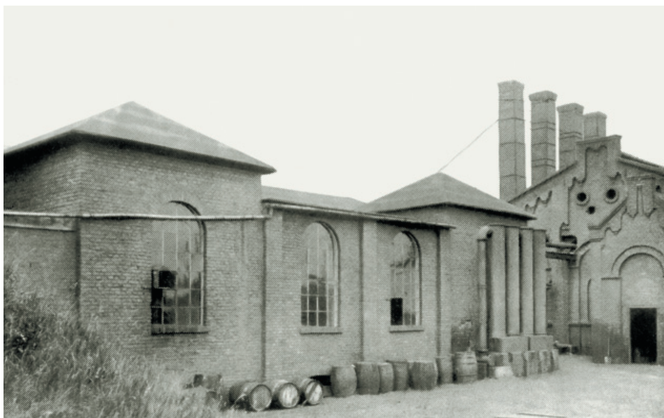
Blick aus Richtung des heutigen Theodor-Heuss-Rings auf den hinteren Betriebshof im Jahre 1901: Im Vordergrund ist das Apparatehaus zur Kühlung, Regulierung und Reinigung des Gases zu sehen, rechts im Hintergrund das Retortenhaus.
