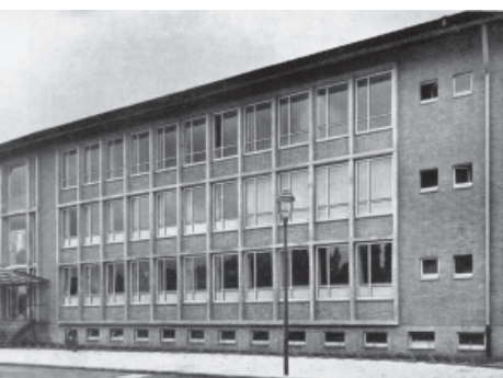
Die Stahlskelettbauweise der 50er Jahre verleiht dem Altbau an der Ebertstraße auch heute noch seinen unverwechselbaren Stil
